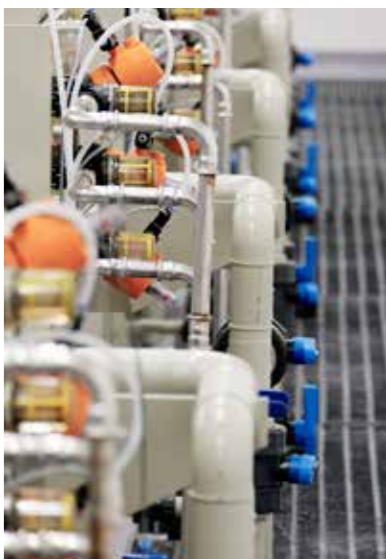
Hver forsøktank har sensorer for overvåking av blant annet pH, oksygen og nitrogen.
